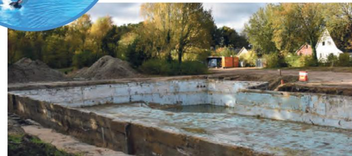
Das Freibad im „Delphino“ wird saniert. Das Außenbecken von 1954 wurde untersucht und als Unterkonstruktion für tauglich befunden. Künftig werden die Freibadbesucher in einem Edelstahlbecken schwimmen. Spätestens im kommenden Sommer soll alles fertig sein.
